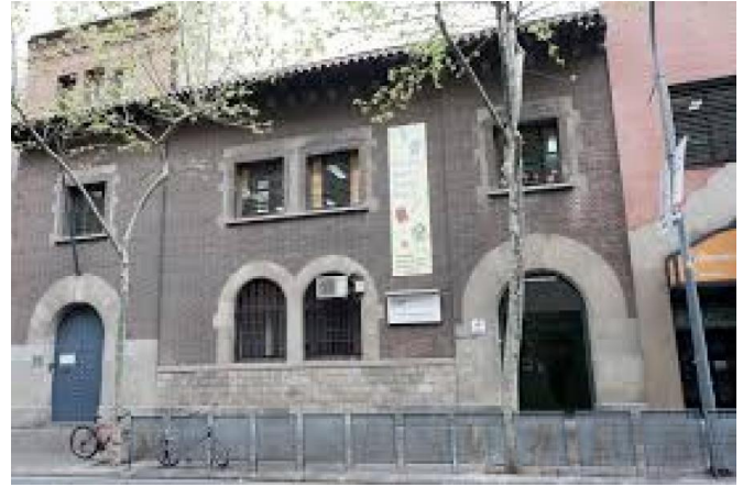
Col·legi Sant Josep Oriol. Façana actual del carrer Villarroel
