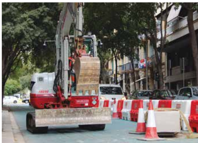
Un dels carrers on s'han iniciat les obres de la superilla
